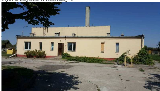
Rys. Budynek techniczny 1
