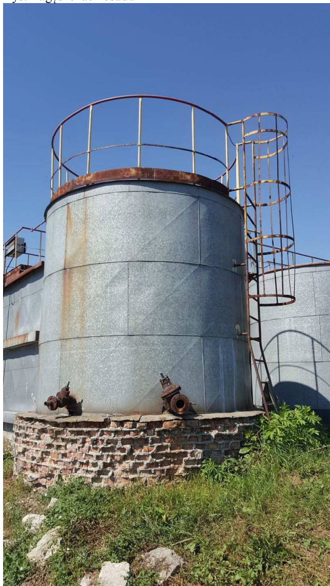
Rys. Zagęszczacz osadu
